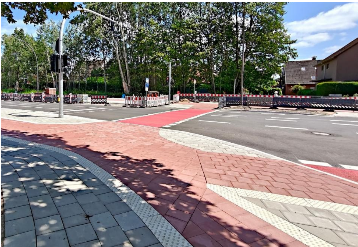
An der Elbgaustraße werden Fahrbahn, Geh- und Radwege sowie barrierefreie Querungen grundlegend modernisiert. Die Arbeiten sollen bis 2027 abgeschlossen werden.
